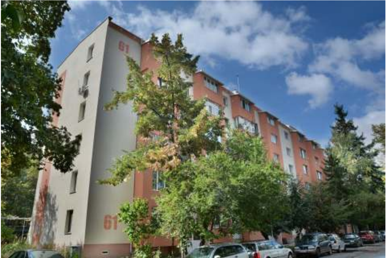
Снимка: бл. 61, част от Националната програма за енергийна ефективност на жилищните сгради
